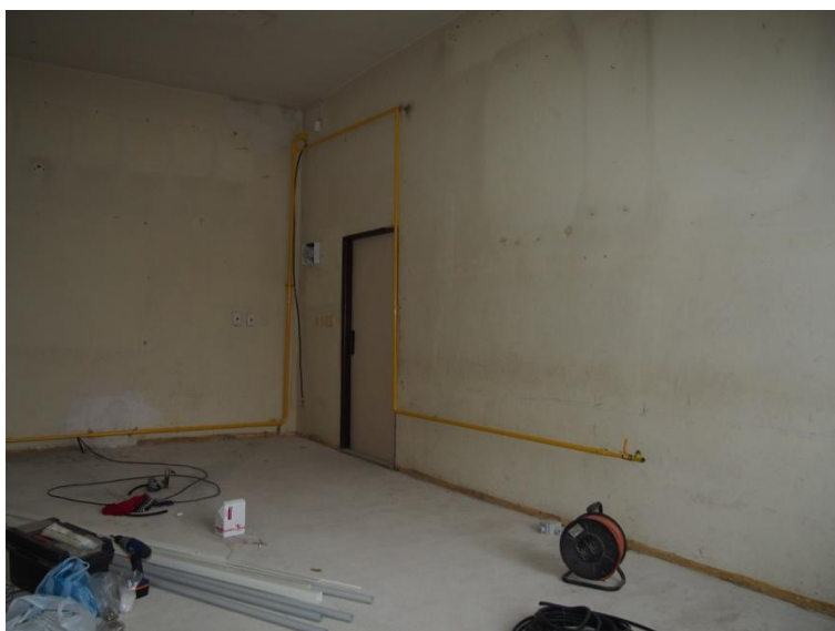
Biologické laboratórium-inštalujeme plyn
